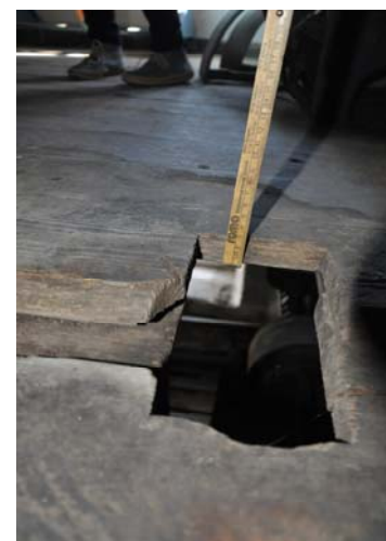
Decke oberhalb Geschirrsaal
