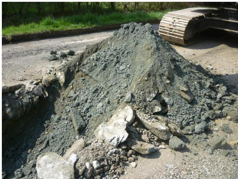
*Bild 4 / 5: lehmige Schicht unter der Packlage*
