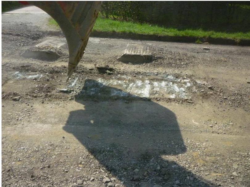
Bild 3: Packlage unmittelbar unter dem vorh. Asphalt
